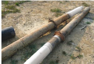
Tubo de acero rehabilitado
